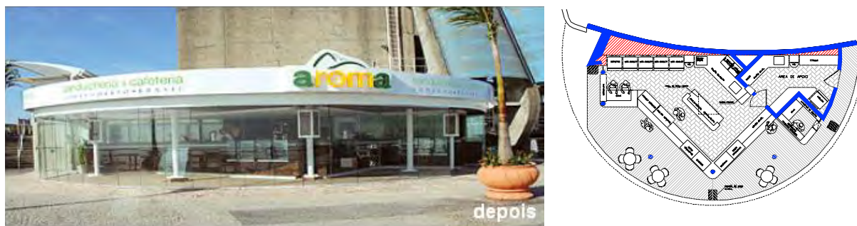
Figura 6 – A cafeteria no dia seguinte a sua re-inauguração (julho, 2007). Vista e planta baixa
