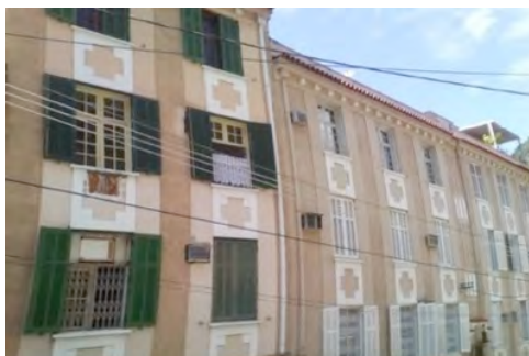
Figura 7. Trecho dos edifícios da rua – fotografia efetuada no primeiro percurso.
