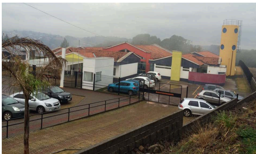
Figura 1. Vista frontal da EMEI "A"
